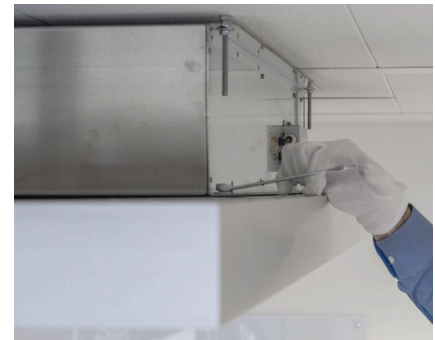
Abbildung 3: Lösen der Mutter (M8).
