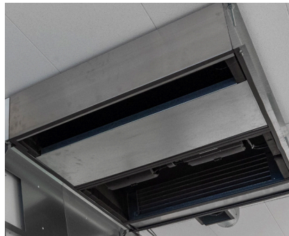
Abbildung 5: Revisionsöffnung für Ventilator und Wärmeübertrager.
