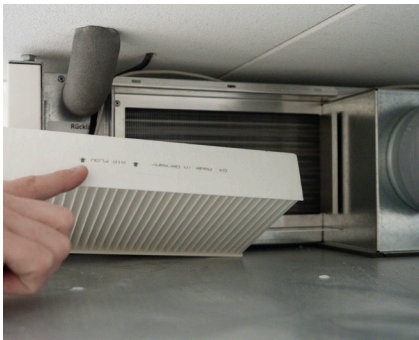
Abbildung 1: Einsetzen der Filterzelle (als Ersatzteil erhältlich)
